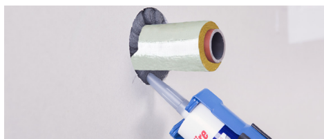
Sellado de tubos metálicos
